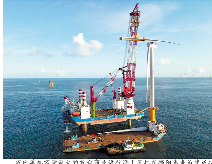
省内单机容量最大的首台商业运行海上风机在揭阳惠来吊装成功
