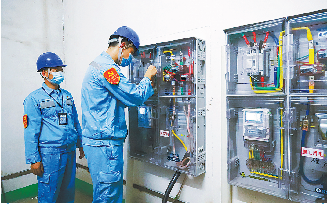
深圳供电局工作人员正在安装为工业园区终端客户供电的计量表计,以便实现抄表到户 黄志伟 摄
