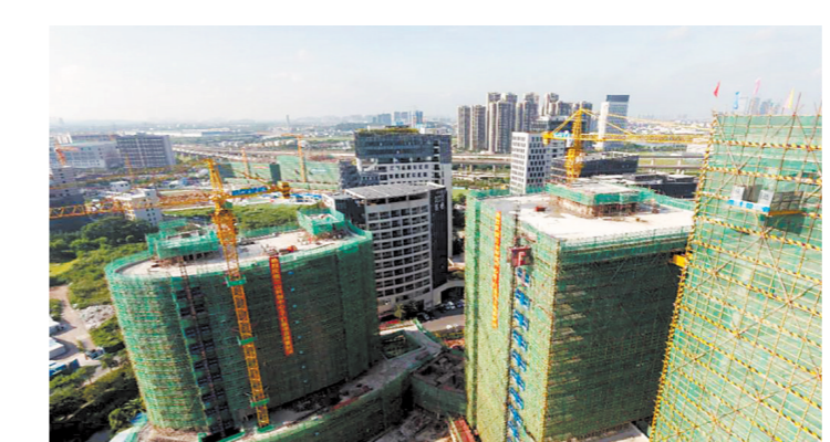
三山科创中心B区项目主体结构封顶 三龙湾南海建设局供图
