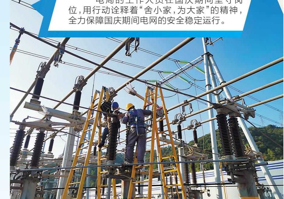
国庆假期,中山供电局变电管理一所工作人员监管220千伏锦绣变电站刀闸检修工作 姜俊和 摄
