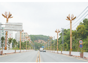
照明设备整改后的街道
