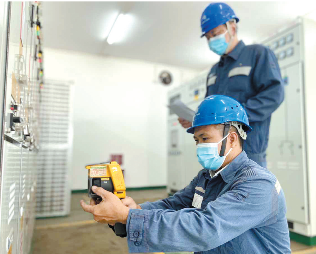
佛山顺德供电局工作人员上门为用户开展用电检查 曾颖华 摄
