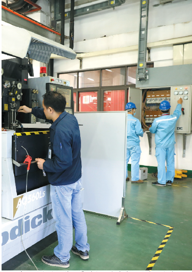
中山供电局工作人员到企业生产车间检查用电安全
