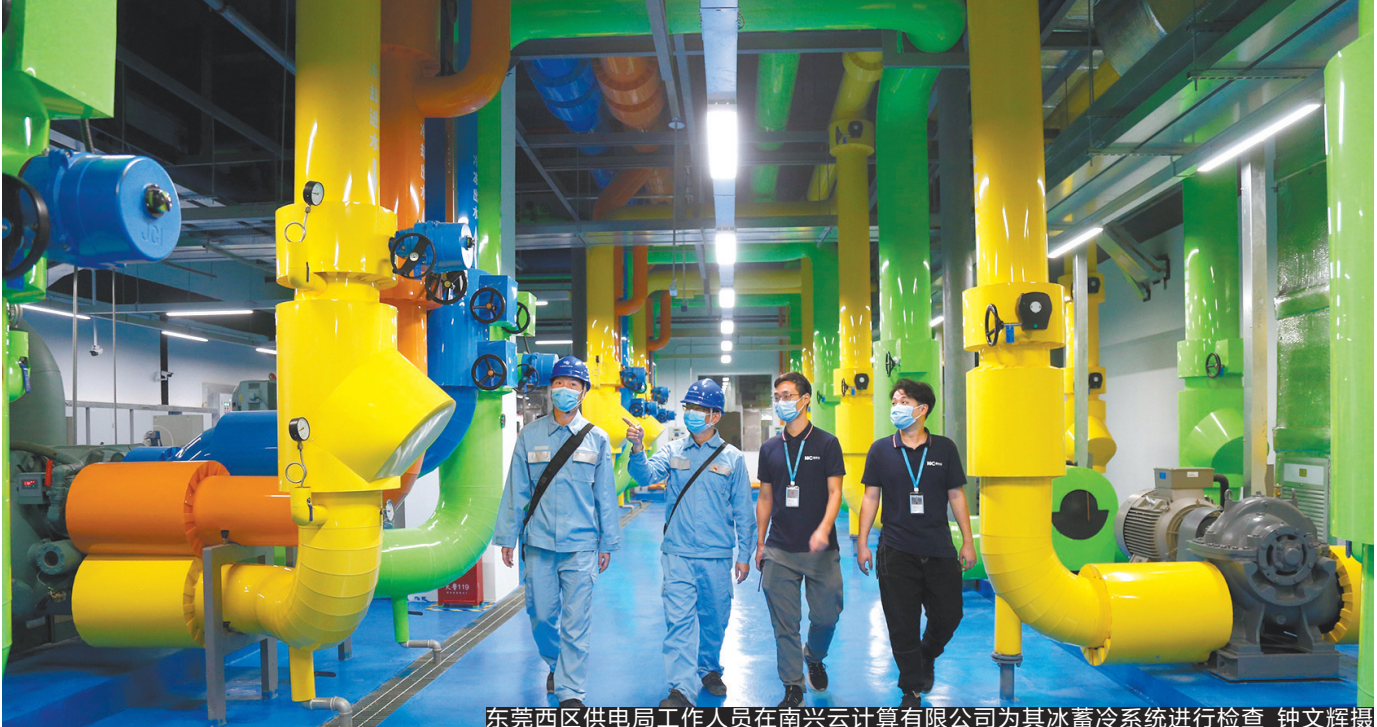
东莞西区供电局工作人员在南兴云计算有限公司为其冰蓄冷系统进行检查 钟文辉摄
