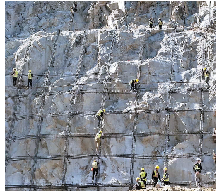
马田街道2021年危险边坡治理工程全面完工
