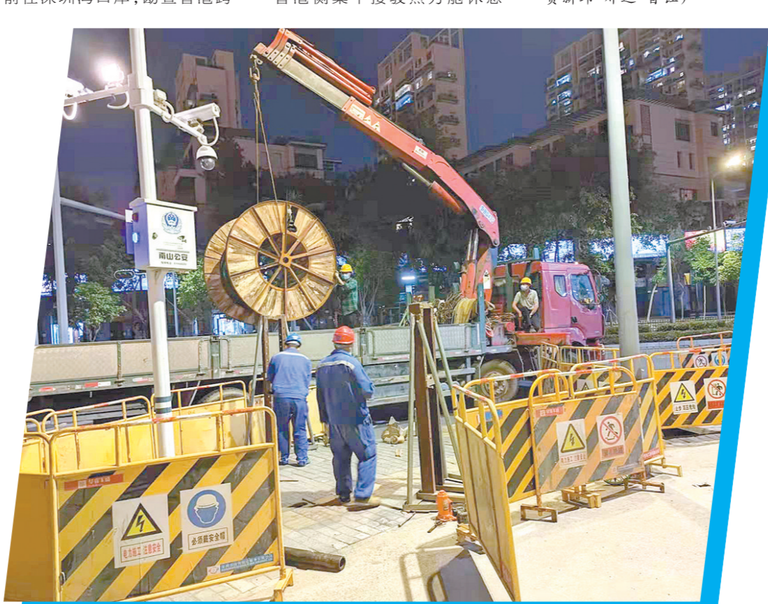
深圳湾口岸施工现场
