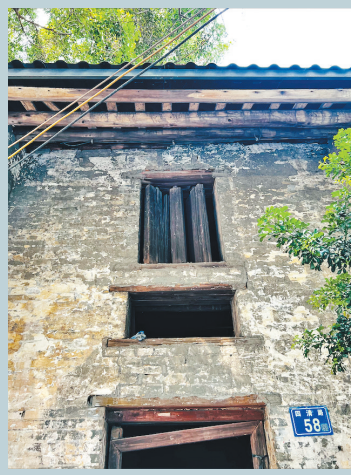
古人为了防洪逃生设计的“大水窗”，窗上的浮木可以拆卸
