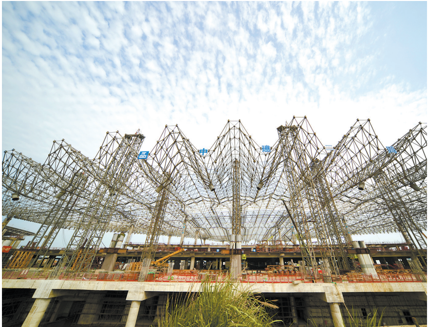
T2航站楼主楼钢结构网架完成整体提升
