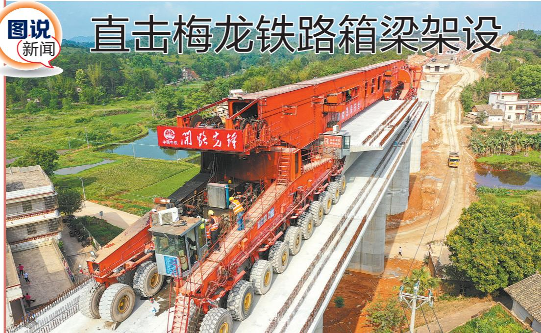
羊城晚报讯 记者王磊，通讯员李长海、赵鹏摄影报道：4月24日，自重达530吨“大国重器”SLJ900运架一体机载着全长32.6米、重达790.3吨的一孔箱梁，从梅龙铁路五华项目部制梁场出发，以每小时3公里的速度，往龙川方向罗洞坑特大桥继续它的架梁任务，经过一个多小时的运输，两个多小时的施工作业后，预制箱梁安稳落于桥墩之上，梅龙铁路又向前迈进了一小步。
