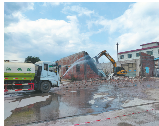
杏坛镇已拆除8万平方米涉水违建
