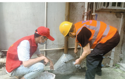
修复渗漏排污水管
