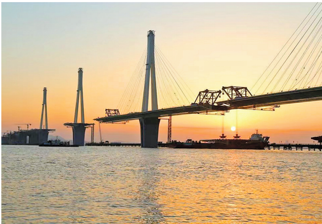
建设中的金海大桥
