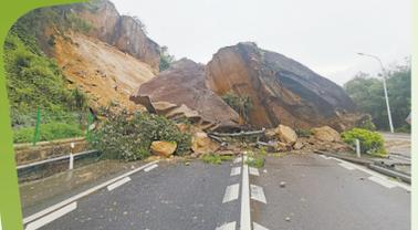
受强降雨影响,此前沈海高速深汕东段发生山体滑坡,大量土石滚落路面
