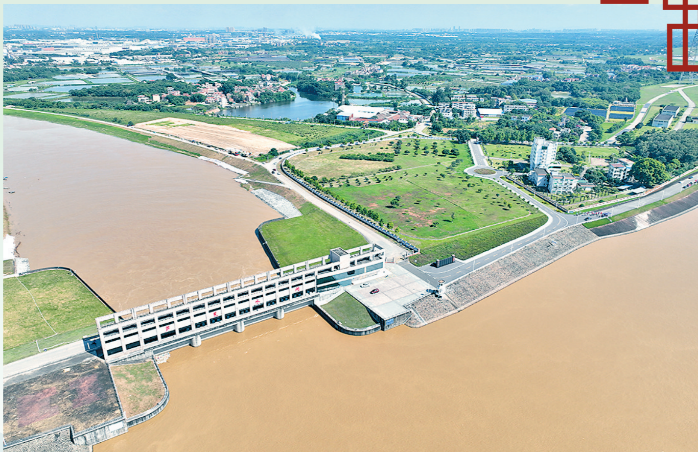
此次抗洪行动中,芦苞水闸发挥了重要作用
