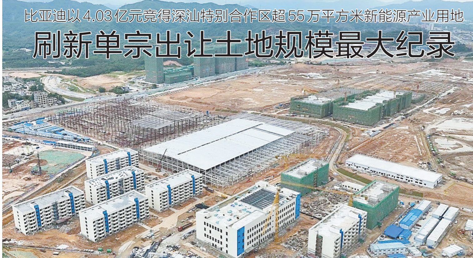
比亚迪汽车工业园(深汕)一期项目建设现场
