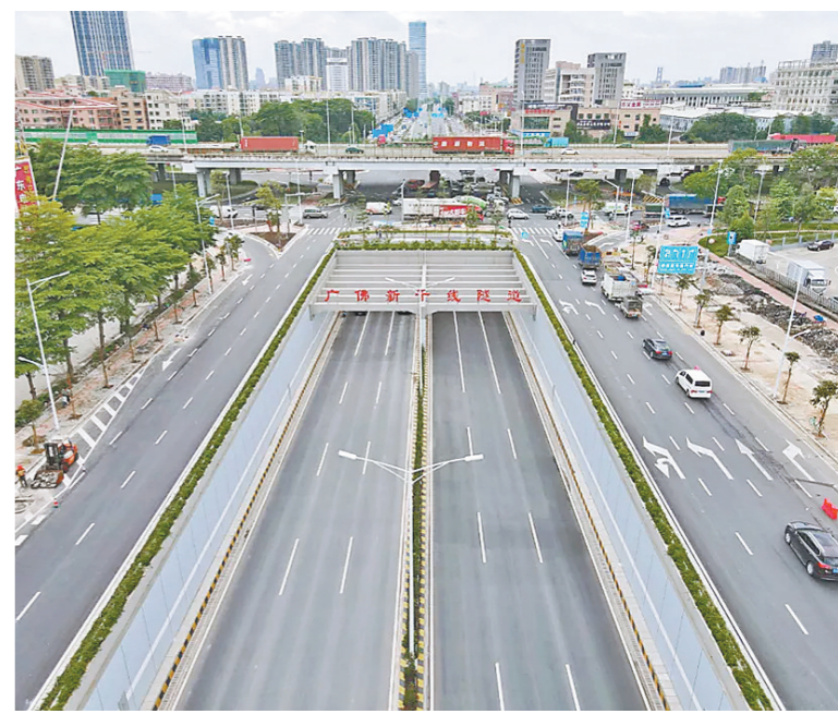
广佛新干线隧道
