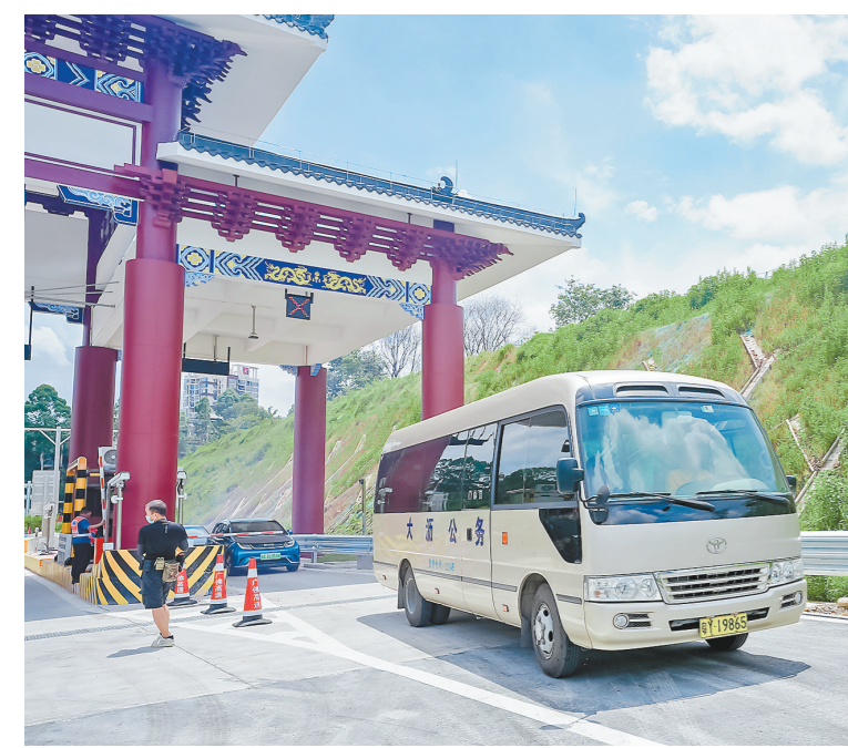
泌冲出入口开通后大大改善了往来居民通行体验
