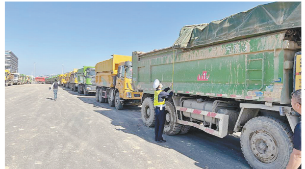
高栏港交警前后护航51天，确保填土工作顺利完成
