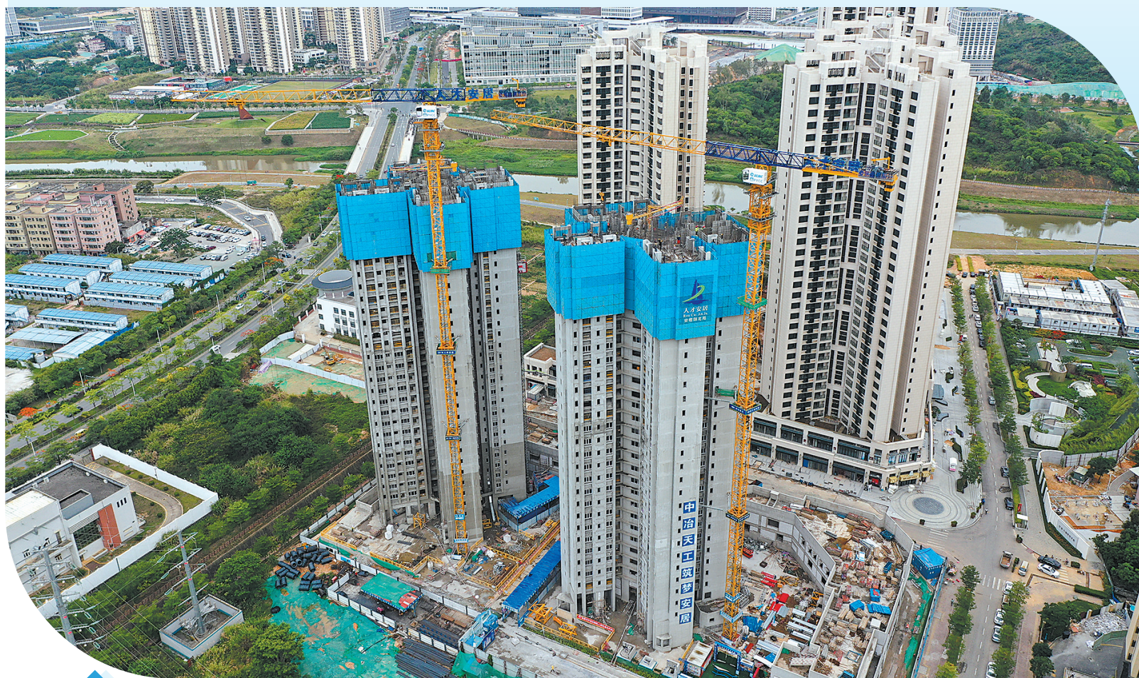
坪山区一处在建住宅楼
