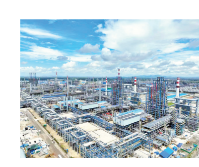
中石油广东石化项目建设现场 通讯员供图
