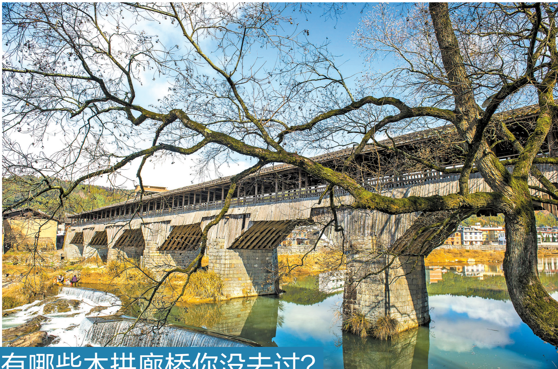
被大火烧毁前的万安桥 视觉中国
