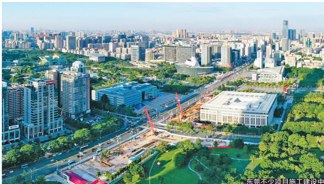
东莞不少项目施工建设中
