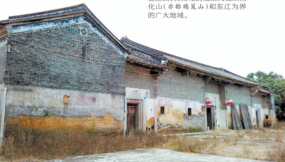
梁化保留着众多明清时期古建筑 受访者供图
