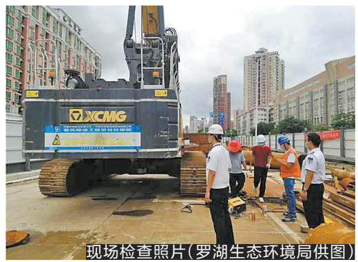
现场检查照片(罗湖生态环境局供图)
