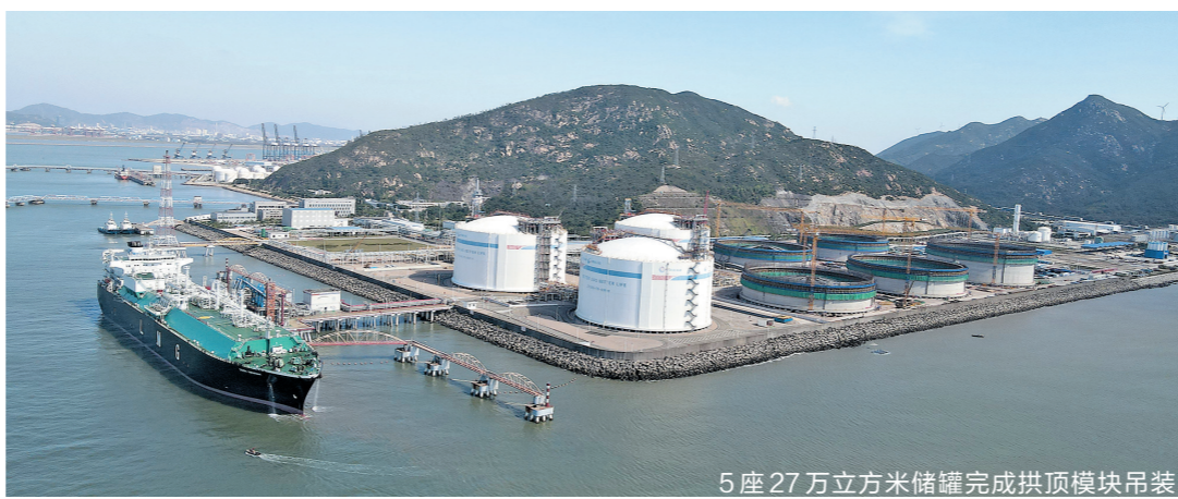
5座27万立方米储罐完成拱顶模块吊装
