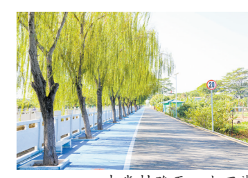
中堂村路面一尘不染
