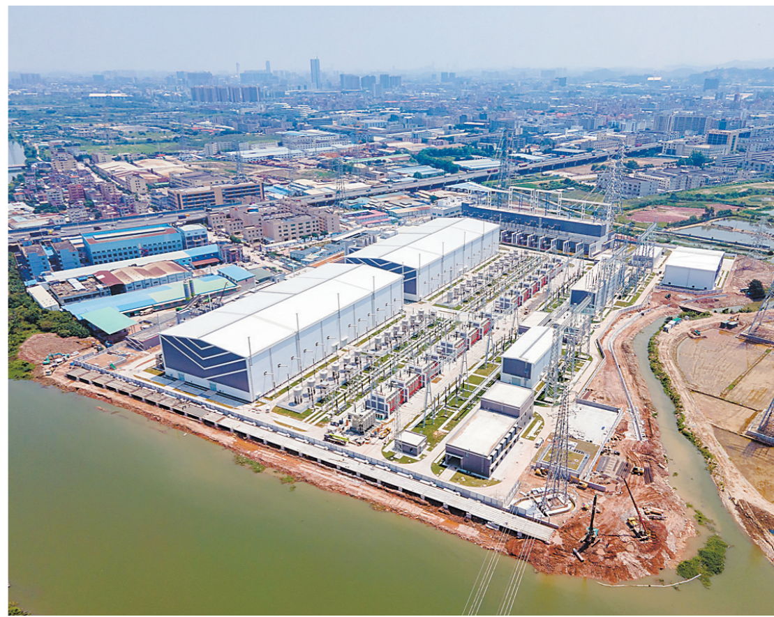
大湾区直连背靠背电网工程(东莞工程) 陈振良 摄
