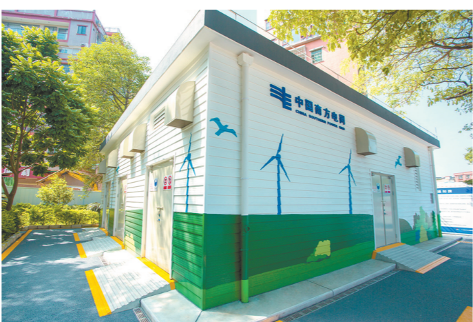
新型电力系统样板工程近景 东莞供电局供图
