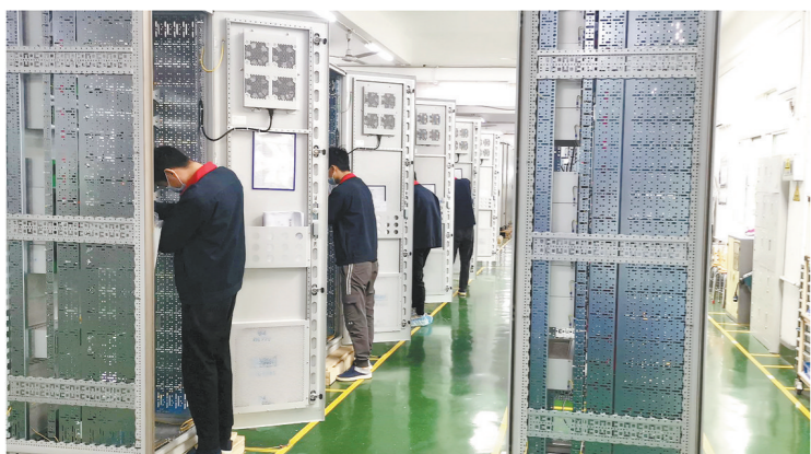
科安达西丽工厂车间的工作人员正在进行检测工作
