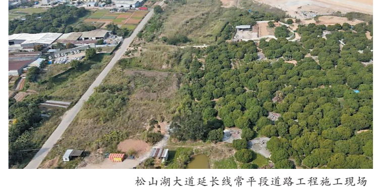
松山湖大道延长线常平段道路工程施工现场
