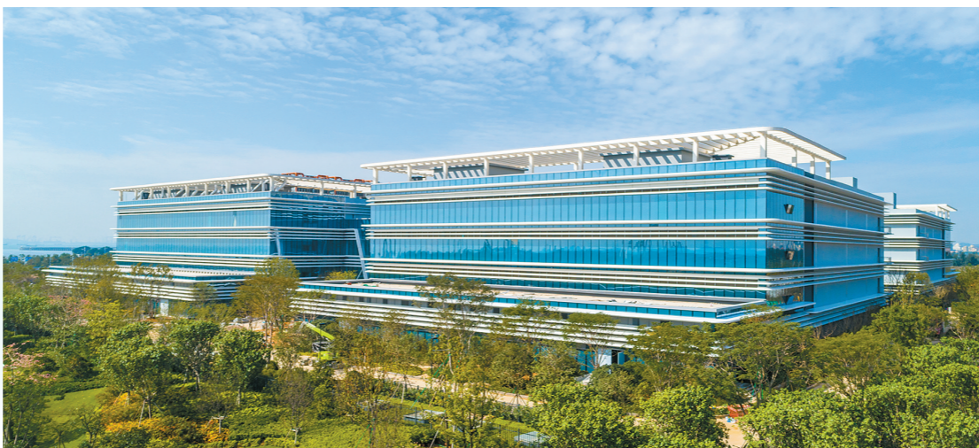
OPPO智能云(大湾区)数据中心
