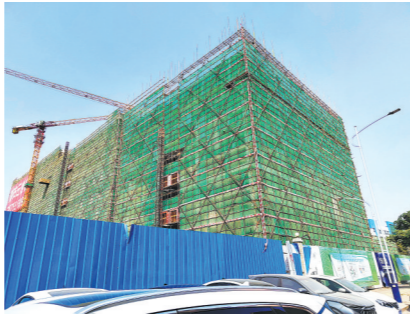
都市云创谷项目部分楼栋已经封顶
