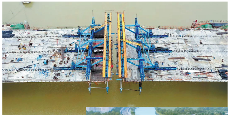
项目施工现场
