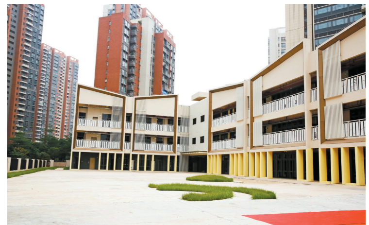
幼儿园实景图 梁雪君 摄
