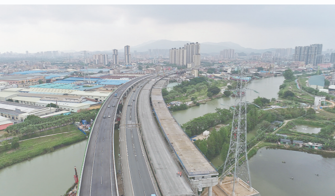
下穿高压线成功合龙的睦洲大桥 中交二航局供图
