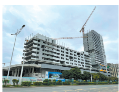
商务区北部学校主体结构已封顶
