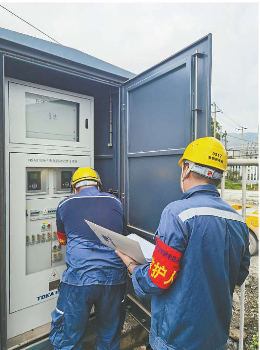
工作人员巡护配电自动化馈线终端 深汕供电局供图
