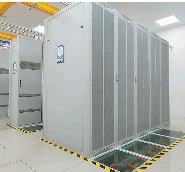
汕汕高铁通信系统工程首件定标在惠东站顺利完成
