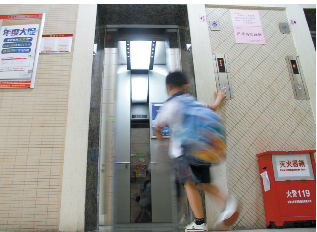
电梯投保维修方式相较申请使用住宅专项维修资金,处理效率将显著提升(资料图) 羊城晚报记者 王俊伟 摄
