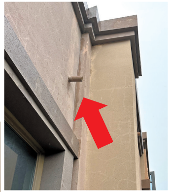
天面层的溢水管直接朝向五楼阳台
