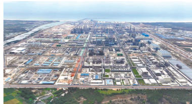
中国石油广东石化炼化一体化项目
