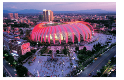
五华县城标志性建筑——五华奥体中心 张炳锋 摄
