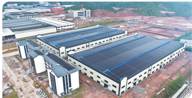
位于梅州平远高新区的广东灿阳智能电力设备有限公司 袁志鹏 摄
