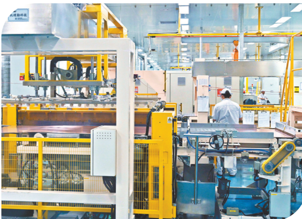
广东盈华高性能覆铜板项目生产车间 袁志鹏 摄
