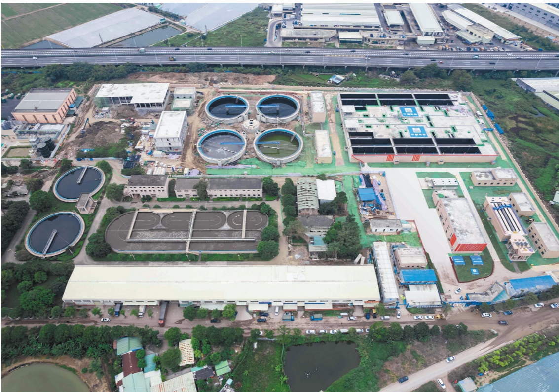
位于小榄镇的东升污水处理厂扩建工程 受访者供图
