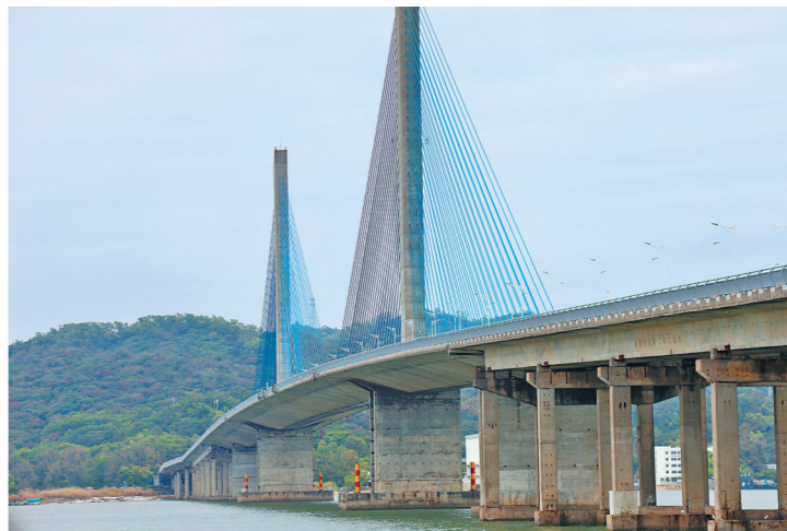
横跨在金星门水道上的洪澳大桥
