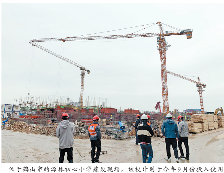
位于鹤山市的源林中心小学建设现场。该校计划于今年9月份投入使用
