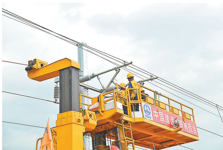
工人正在进行落锚作业
