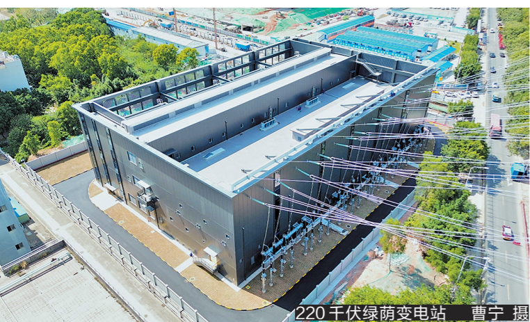
220千伏绿荫变电站 曹宁 摄
